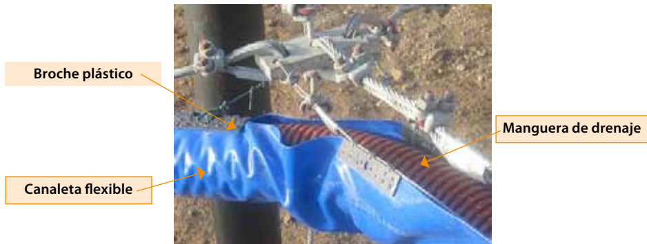
Foto 4.30: Elementos de una canaleta (Proyecto Atrapanieblas).
