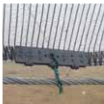
Fotos 4.20, 4.21, 4.22 y 4.23: De izq. a der., Malla Polietileno Alta Densidad; Broche rectangular; Instalación de alambre y broches. Abajo, resultado de la instalación (Proyecto Atrapanieblas).
