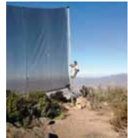
Fotos 4.34, 4.35 y 4.36, en sentido de reloj: Peldaños portátiles pueden ser montados a los postes para ascender con seguridad a la parte superior del atrapanieblas. (Proyecto Atrapanieblas).
