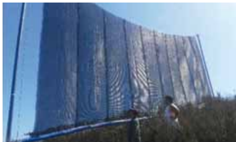
Fotos 4.32 y 4.33: Atrapanieblas montados en Majada Blanca, IV Región (Proyecto Atrapanieblas).
