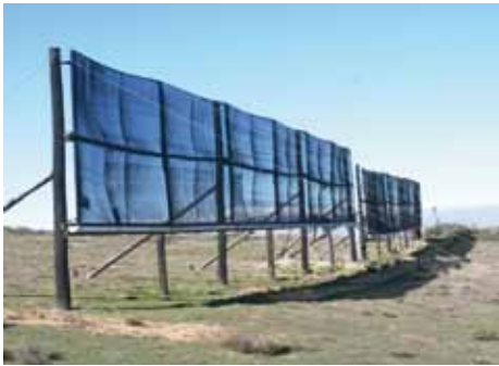
Fotos 3.3 y 3.4: De izquierda a derecha, atrapanieblas con estructura de marco rígido en Peñablanca, Chile (R. Holmes) y con tenso-estructura en Alto Patache, Chile (P. Cereceda)
