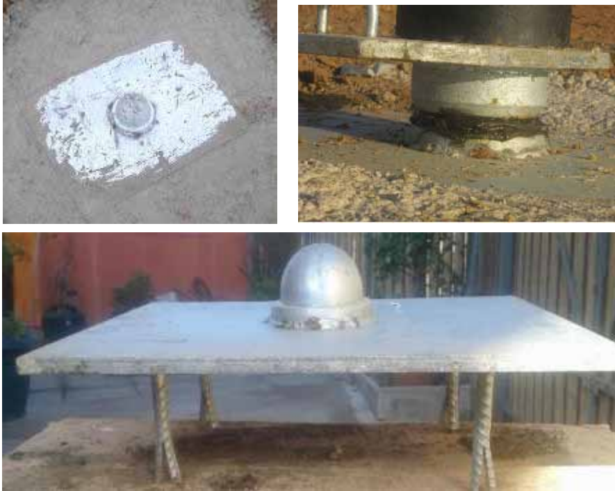
Fotos 4.12 (Inferior), 4.13 (Superior izquierda) y 4.14 (Superior derecha): Montaje del apoyo de rótula (Proyecto Atrapanieblas).
