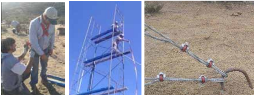
Fotos 4.17, 4.18 y 4.19: De izq. a der., Elementos de seguridad; ascenso y colocación de postes y uniones; colocación de grampas y guardacabos. (Proyecto Atrapanieblas).
