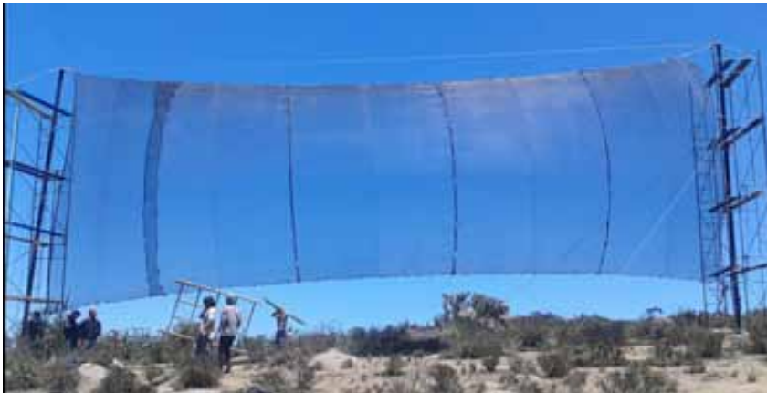
Foto 4.29: Una vez concluido el proceso de instalación de malla, se procede a desarmar la estructura de andamios. (Proyecto Atrapanieblas).
