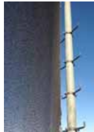
Fotos 4.34, 4.35 y 4.36, en sentido de reloj: Peldaños portátiles pueden ser montados a los postes para ascender con seguridad a la parte superior del atrapanieblas. (Proyecto Atrapanieblas).
