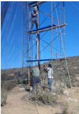
Foto 4.26: Levantamiento de malla (Proyecto Atrapanieblas).
