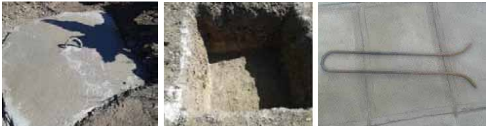
Fotos 4.6, 4.7 y 4.8: Anclaje e instalación de rótulas. (Proyecto Atrapanieblas).
