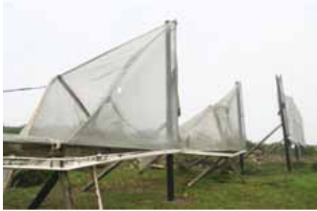
Foto 3.13: Cuando la malla resiste la presión del viento, ésta es transmitida hacia los componentes de la estructura de soporte, generando la destrucción parcial o total del sistema (R. Holmes).
