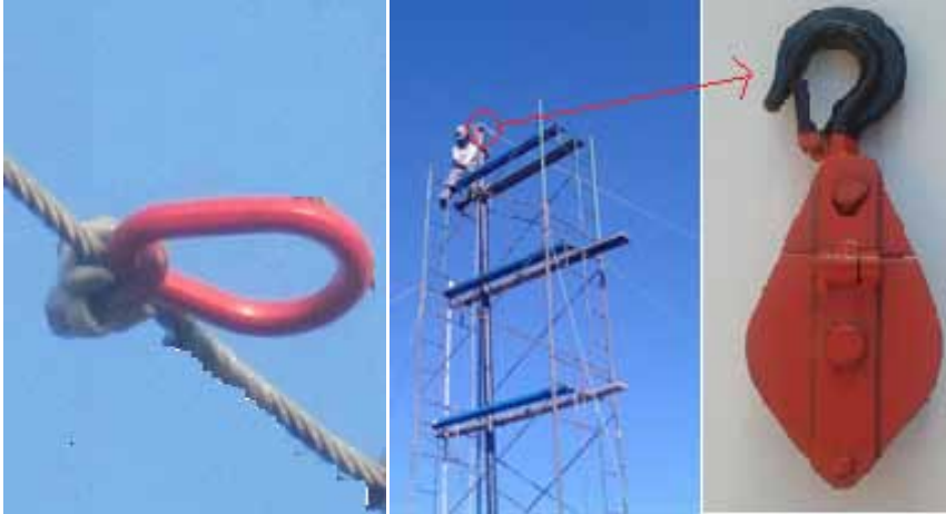
Fotos 4.24 y 4.25: De izq. a der., "Candado Pera" y polea a instalar en uno de los orificios de la cabeza del poste (Proyecto Atrapanieblas).
