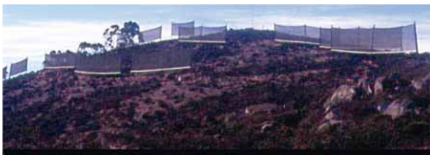
Foto 1.15: Atrapanieblas de El Tofo. Se construyeron en 1987 y su agua se llevó a Chungungo en 1992 (P. Cereceda).
